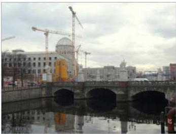
Vue sur le chantier de reconstruction du Chateau de Berlin
